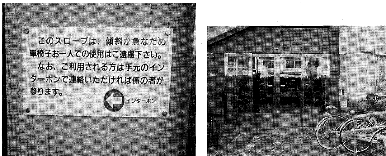
図2：スロープの傾斜に関する注意書き及び車イス用呼び鈴のメンテナンス状況
