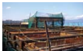
▲最上階の鉄骨工事近景
