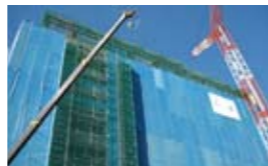
▲工事現場全景
