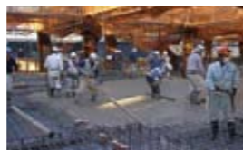
▲最上階のコンクリート打設の様子
