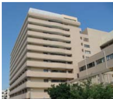
▲完成した西病棟
