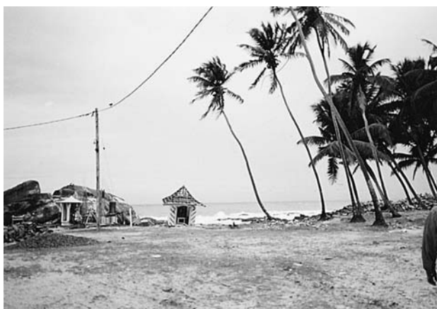
写真3 建物が破壊された仏教(向かって左)とヒンドゥー教の祠
