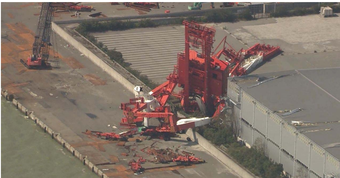
図 1.9 平成 30 年台風 21 号における荷役機械倒壊状況（尼崎西宮芦屋港） 7)
