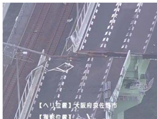
図 1.7 平成 30 年台風 21 号における関空連絡橋タンカー衝突 7)
