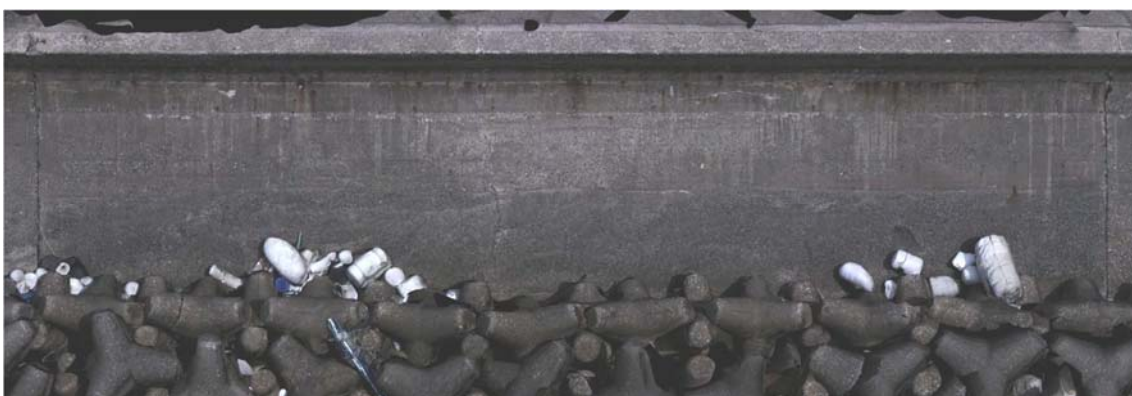
図 2.3 撮影写真からの展開図作成（護岸前面）
