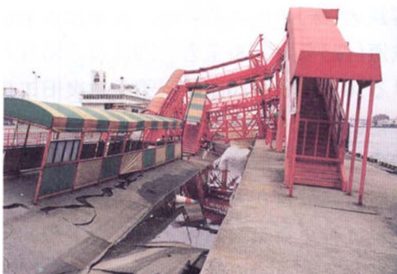
図 1.6 1995 年兵庫県南部地震における東神戸フェリー埠頭被災状況 6)
