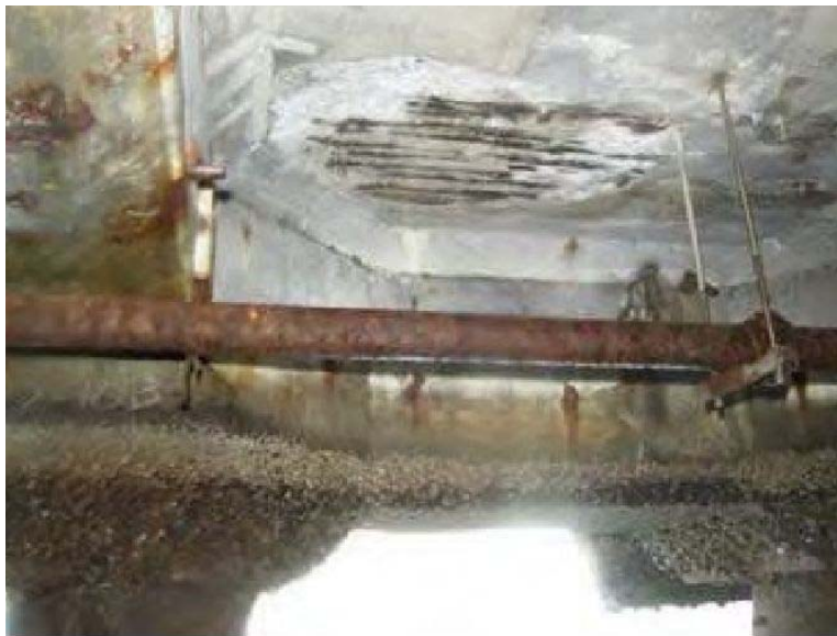
図 3.15 栈橋下面の状況（現地試験実施時点では補修済）
