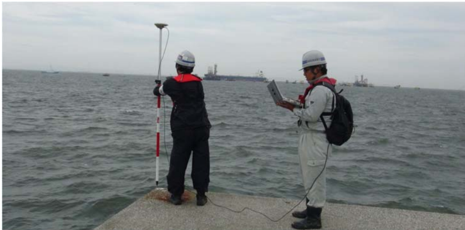
図 2.14 GCP（標定点）の測量状況
