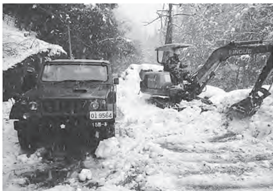
写真-1 自衛隊との雪害道路啓開作業
