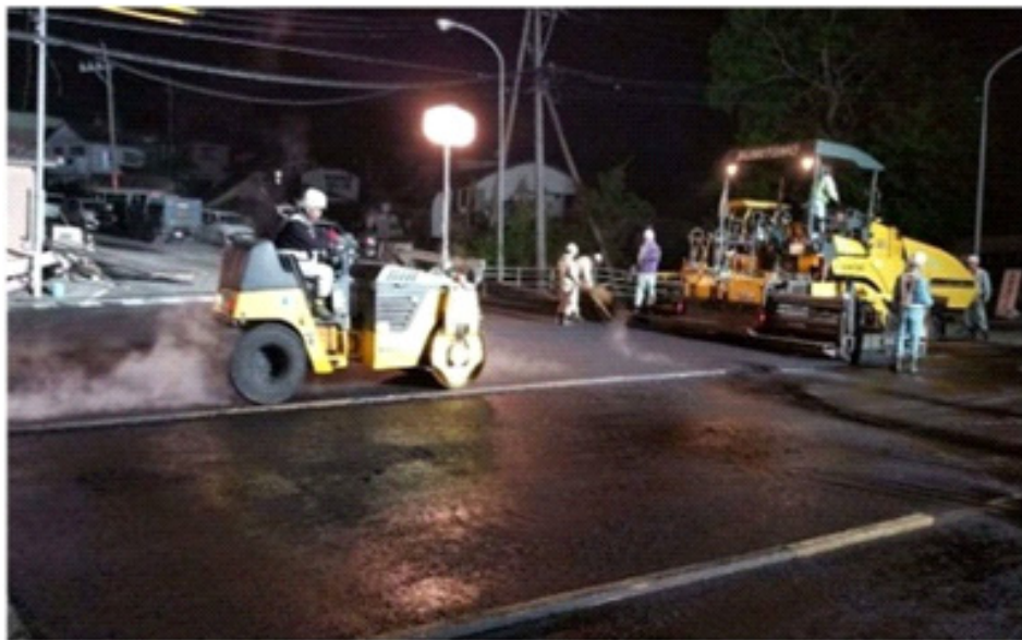
写真-1 交差点復旧状況（国道443号線寺迫交差点応急工事， 平成28年4月18日～20日，（一社）熊本県建設業協会提供）
