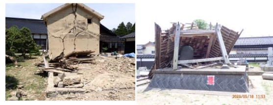
写真-3 寺院の被害例 (いずれも珠洲市正院町)
