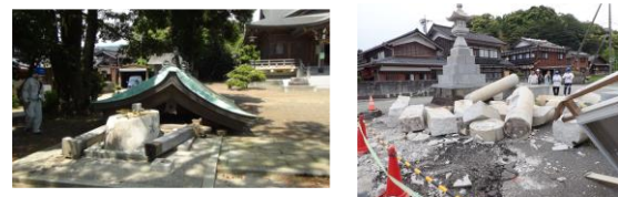
写真-4 神社の被害例 (左: 珠洲市正院町, 右: 珠洲市三崎町)
