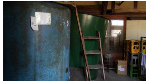
写真-2 傾斜した貯蔵タンク
