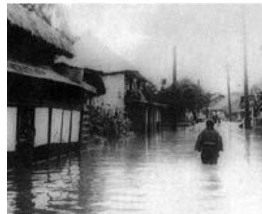
図-2 塩川町の浸水被害(昭和16年7月23日台風)
