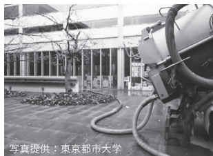
写真－2 ポンプ車で排水
