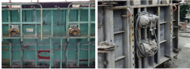
図 2.3 外部振動機の取付け状況
