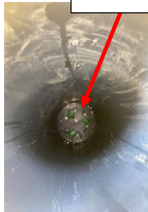
図 7.7 塩化ビニール管内部
