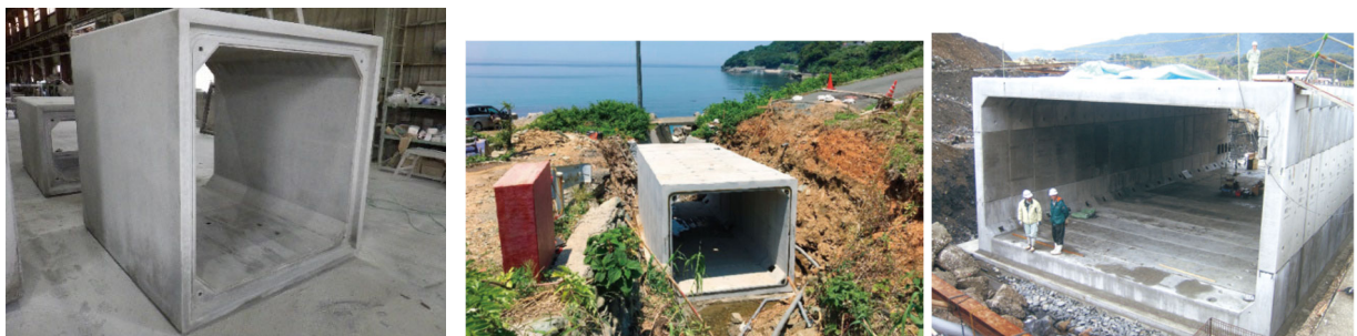
図 6.8 ボックスカルバート（製品，施工状況）
