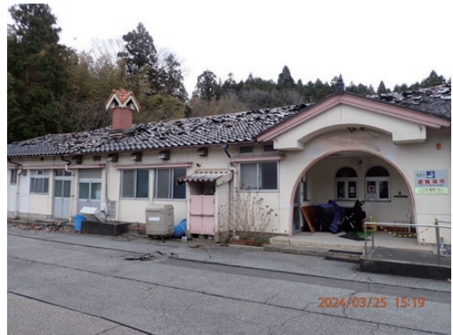
写真3 N-3園の被害状況
