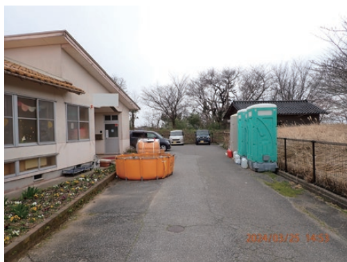
写真5 N-2園に設置された仮設トイレと貯水槽
