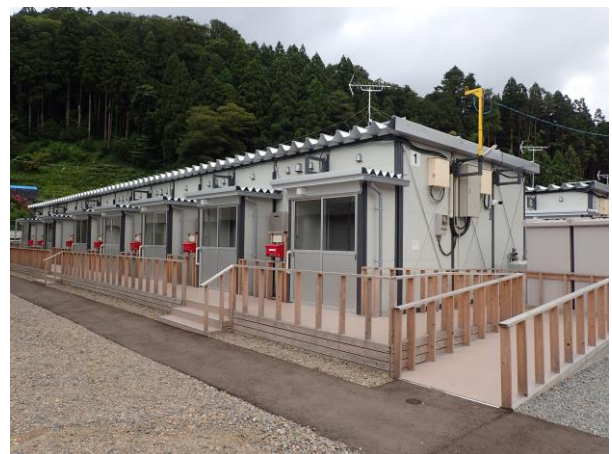
図-3 仮設住宅（輪島市立河原田小学校敷地内）
