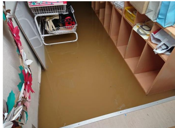
写真-2 I-3 幼稚園教材庫内の浸水状況 (I-3 幼稚園提供)
