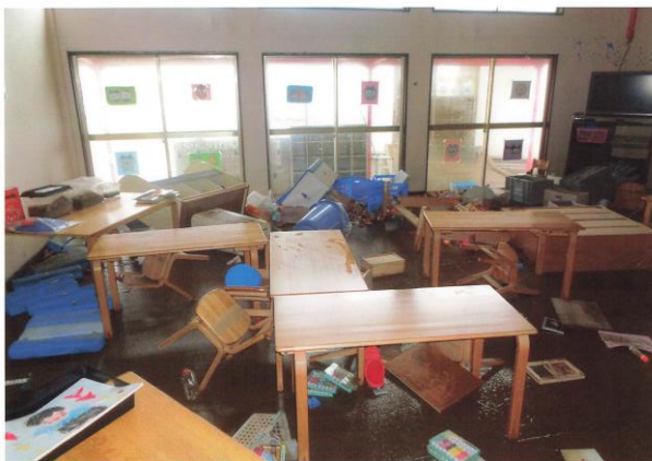
写真-3 K-1 幼稚園内の被害状況 (K-1 幼稚園提供)
