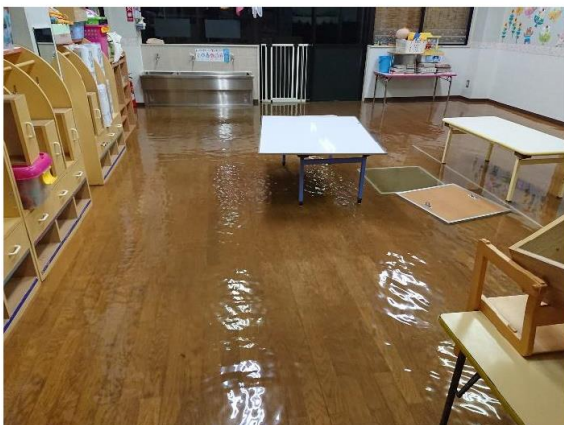
写真-1 I-3 幼稚園の保育室内の浸水状況 (I-3 幼稚園提供)
